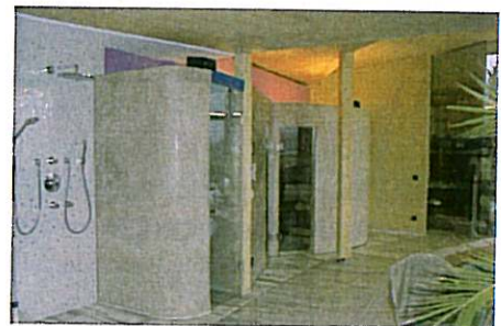
In Bad und Sauna wurde mit Tadelakt, einem alten Traditionen im Bäderbereich entstammenden und besonders widerstandsfähigem Material auf Kalkbasis gearbeitet
