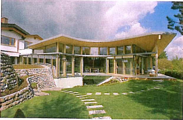
Aufwändig wurde eine Villa aus den 60er Jahren umgebaut. Neu ist der Holzanbau
