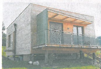
Auf Erdarbeiten konnte fast gänzlich verzichtet werden.
