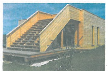
Aus den ursprünglich geplanten Schattenslamellen wurde eine „Himmelsstiege“.
